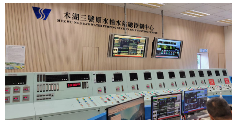
定期於木湖原水抽水站監測東江水水質。
