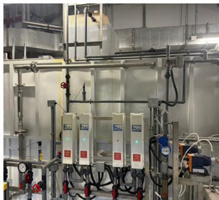
薄膜生物反應器 Membrane Bioreactor Tank
