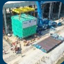
混凝土外牆板件以製造及裝配式設計方法安裝至食水抽水站
