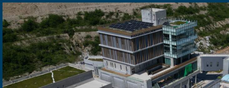
現場氯氣生產大樓上的綠化屋頂，以及逆滲透淨化大樓屋頂上的太陽能板。 Green roof on top of the On-site Chlorine Generation Building and PV panels on the roof of Reverse Osmosis Building.
