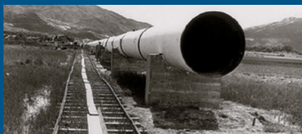
香港政府於一九六零年敷設直徑 48 吋的大型輸水管，用於接收來自深圳水庫的原水。
