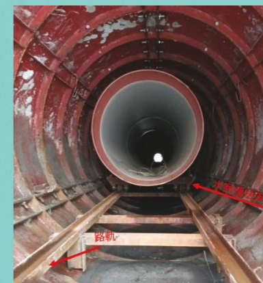
圖三：將水喉安裝上運送架並利用油壓啣及路軌將水喉推前到指定的位置連接及燒內外焊
