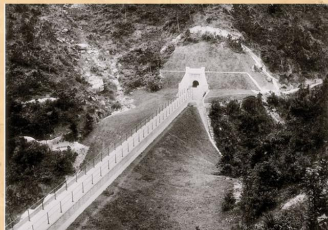
大潭谷供水計劃 (Tytam Valley Scheme) 終於在1883年動工，涉及大潭上水塘、輸水隧道、寶雲道輸水道、阿賓尼沙濾池、阿賓尼配水庫和配水管，全部都在裴樂士任內完成。上圖為輸水隧道的大坑方向出口。裴樂士亦促成香港天文台的成立。
