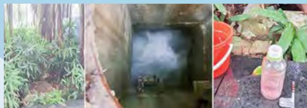
漏損管理組監測到赤柱及紅山監測區域RH-DMA23的漏損情況持續嚴重，情況令人關注。經勘查，赤柱海濱小賣亭老舊消防系統為其中一個主要漏損點，佔總最低晚間流量三分之一；赤柱監獄失水亦佔問題一個重要部分。分區同事優先與建築署合作，於2024年底完成消防系統全面檢修，使該處最低晚間流量銳減至無須特別再深入跟進的極低水平。客戶服務同事亦同步於赤柱監獄邊界加裝電子水錶，並於2024年尾截斷了相關廢棄水管，成功追蹤整個赤柱監獄用水以便日後跟進工作。同時，同事也透過劃分若干子監測區域進行精準管控並測漏及維修，最終監測區域整體最低晚間流量大降八成，成績斐然。
