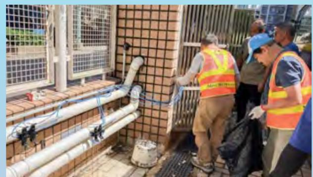
漏損管理組(新界東區)自2023年中開始，發現將軍澳其中一個屋苑的最低晚間流量一直上升。因此，漏損管理組進行多次巡查及使用外置超聲波流量計量度個別入水位置的晚間流量。發現該獨立監測區有多處漏損地方，包括屋苑私家地底喉損壞、損壞的閘閥引致食水缸溢出及監測區內學校的消防系統問題等。經過新界東(客戶服務)視察組同事努力不懈與該監測區的持份者進行多次會議及發出維修通知，使上述持份者在2024年底完成維修。最終，該獨立監測區的最低晚間流量由2023年底高峰大幅減少接近九成，成功節省大量食水。
