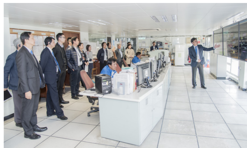
機械工程師呂永傑（右一）向區議員講解屯門濾水廠的分佈式控制系統，並介紹濾水廠各食水處理流程中主要位置的儀器運作。控制室亦設有監控及資源收集系統，可即時監察新界西區各抽水站和配水庫的運作情況。
